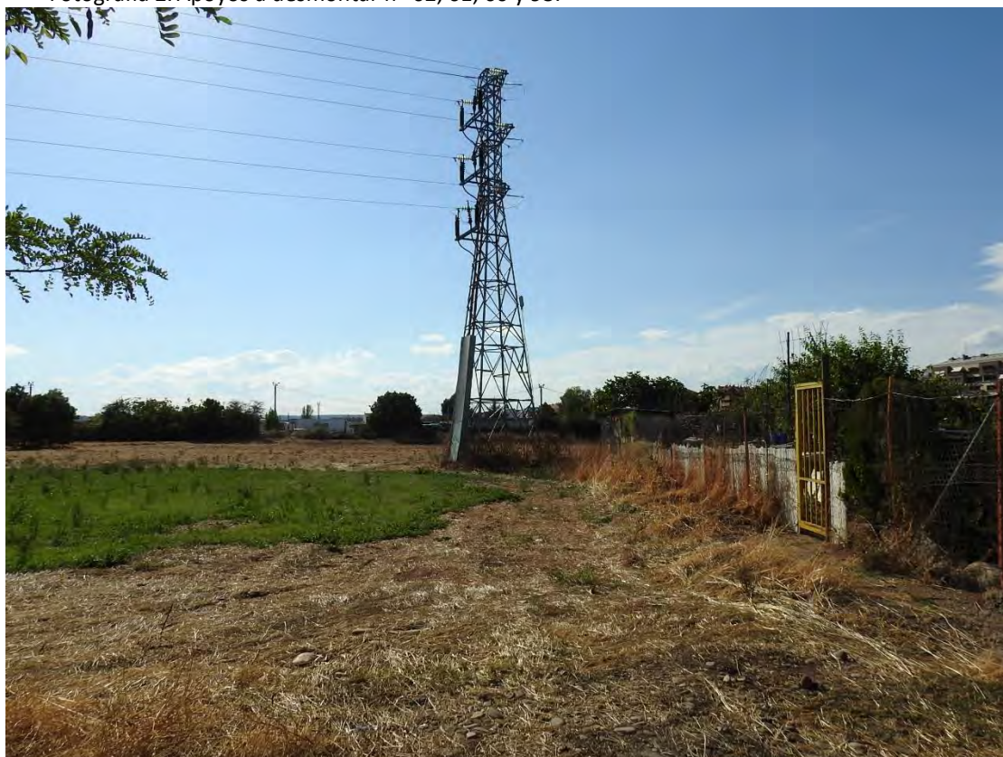
Fotografía 3. Apoyo nº 62 donde se realizará la modificación de la arqueta existente.
