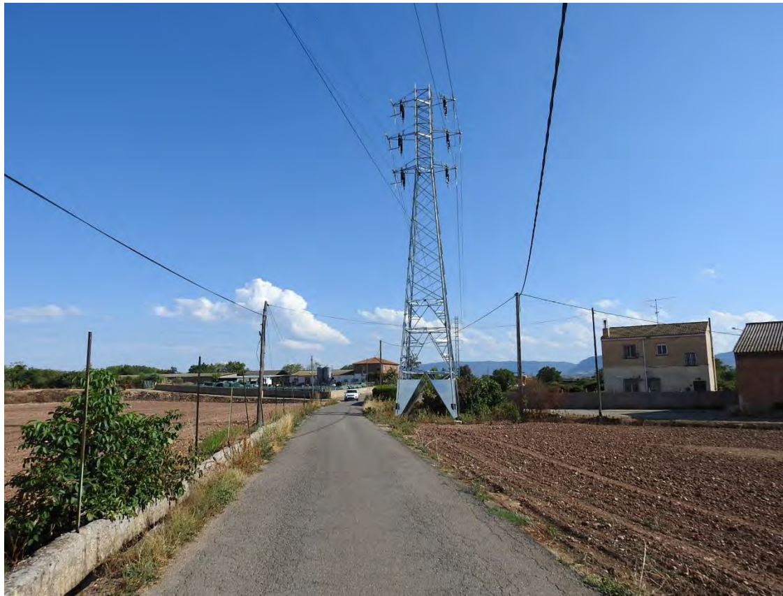
Fotografía 1. Vial asfaltado (Vía pecuaria Colada de la Pasada de La Magdalena) por la que se ha diseñado el trazado en subterráneo. Detalle del apoyo existente, y que se mantiene, nº 58.
