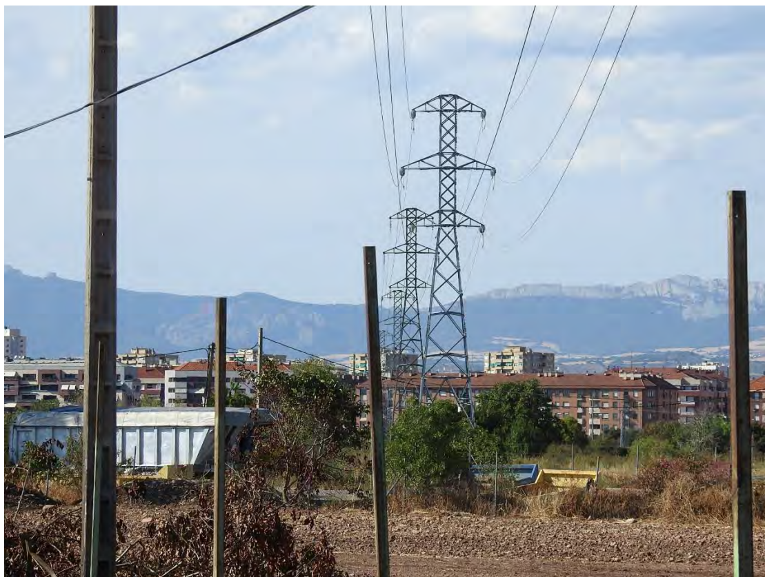
Fotografía 2. Apoyos a desmontar nº 62, 61, 60 y 93.
