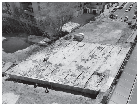
■ Tablero del puente del ferrocarril, antes de su desmontaje.
