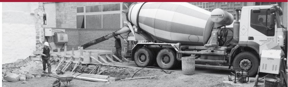
Ya se han iniciado las obras en la calle Los Baños
