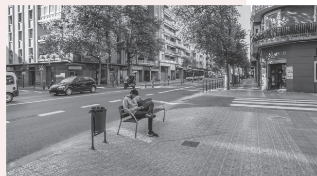
■ Las obras en las aceras de Vara de Rey han servido para ganar espacio público para el peatón.
