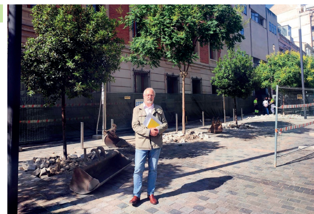
■ Las obras durarán unos dos meses y los contenedores soterrados estarán operativos en septiembre.
