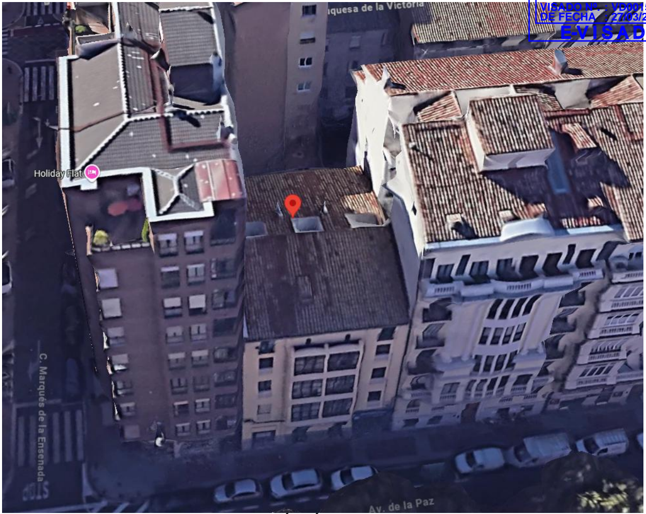
FOTOGRAFÍA AÉREA DEL EDIFICIO
